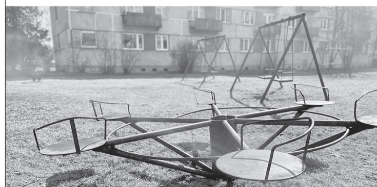
Rēzeknes ielas mikrorajonā Preiļos izceļas ar lielu daudzumu vēsturisko relikviju, vairākos pagalmos slejas metāla konstrukcijas no padomju laikiem, vienā pagalmā pat atrodama ūdenstilpe ar tiltiņu
